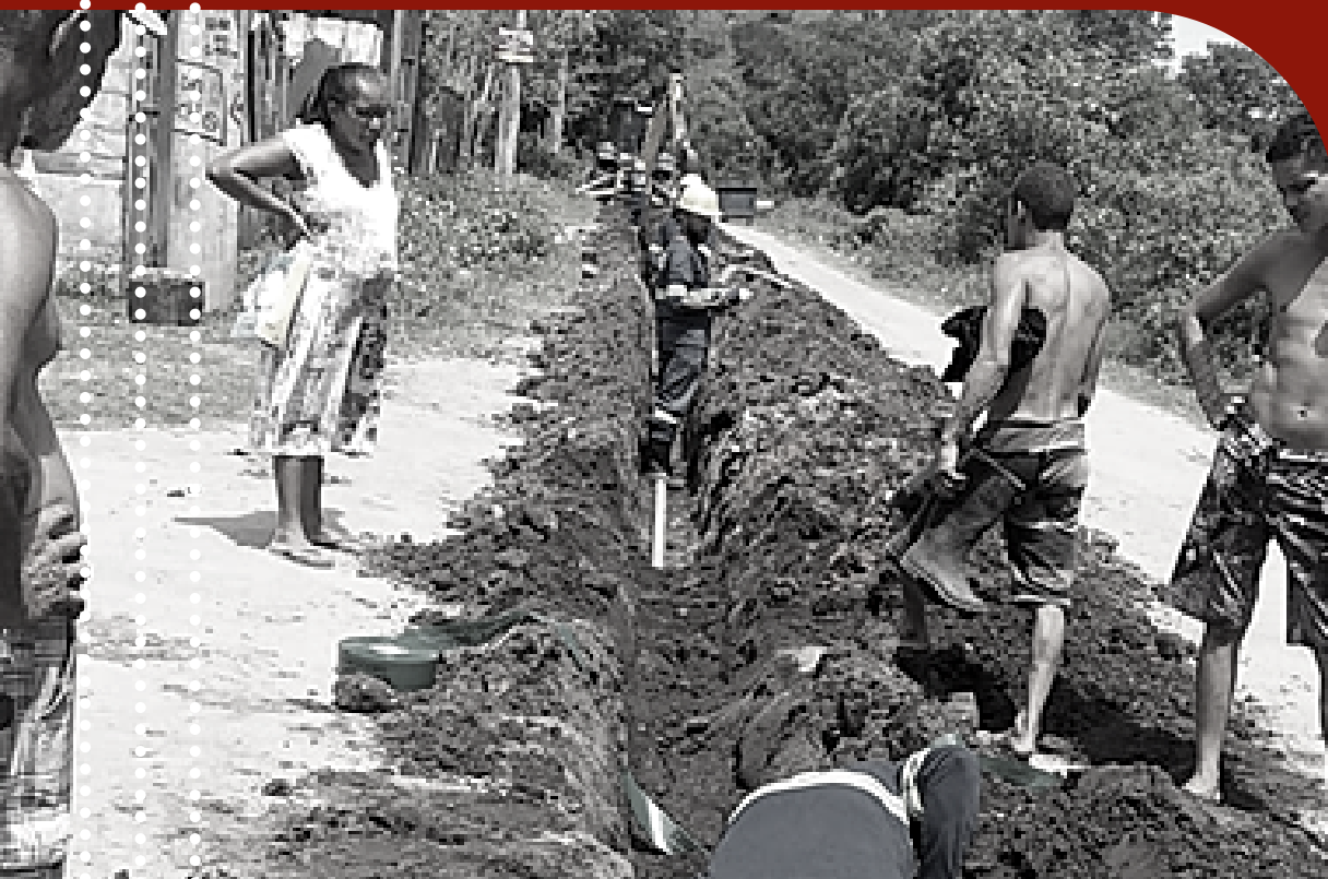
Instalação de rede de abastecimento de água em Morada da Barra, Vila Velha/ES.
